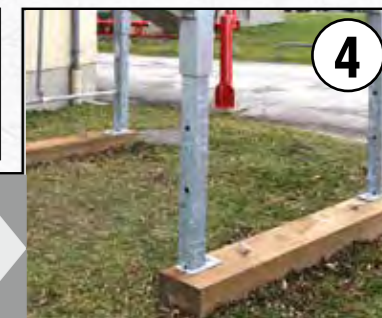
4 Unterlegschwellen Underlay sleeper
